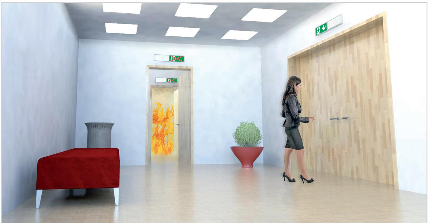
Wird ein Brand durch die Brandmeldeanlage detektiert, können die Pfadfinder-Leuchten flüchtende Menschen sicher aus der Gefahrenzone leiten. Hierzu wird nun der alternative 2. Fluchtweg ausgewiesen. Die Kennzeichnung des 1. Fluchtweges in den Gefahrenbereich ist nun blind.
